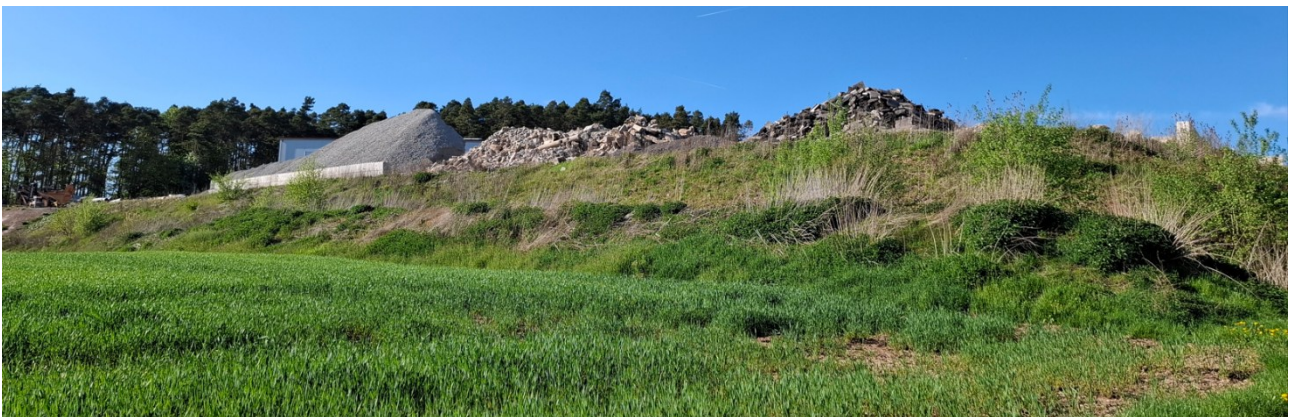
Abbildung 5: Blick von Südosten auf die Böschung als südliche Begrenzung des Firmengeländes; (Foto: Bachmann Artenschutz GmbH)
