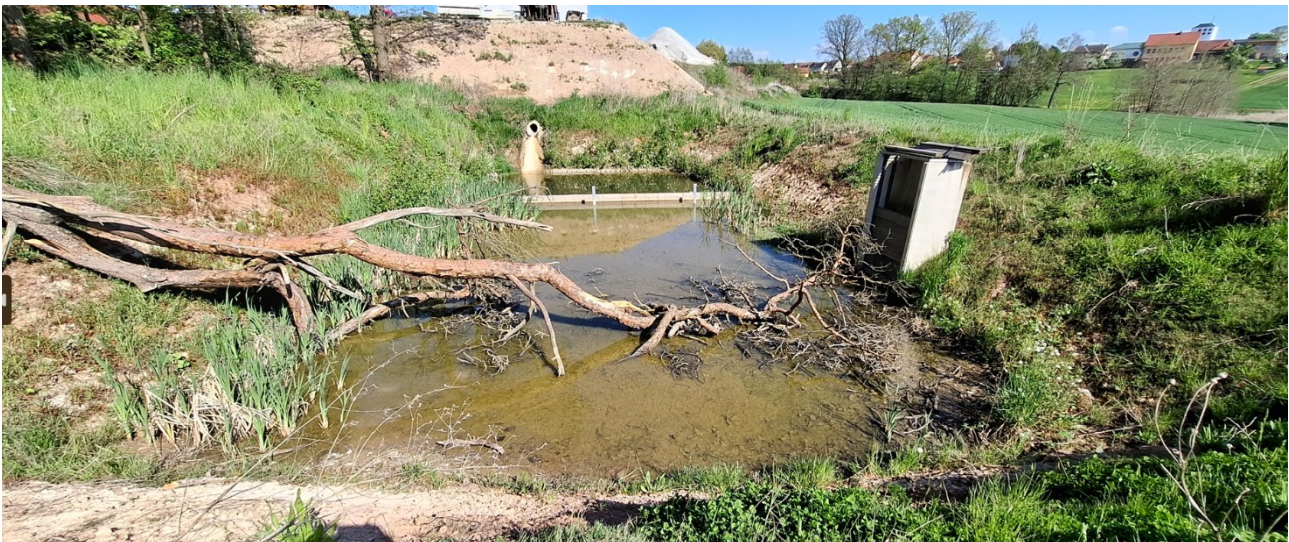
Abbildung 7: Blick von Westen nach Osten auf das Regenrückhaltebecken; (Foto: Bachmann Artenschutz GmbH)
