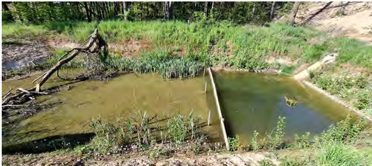
Abbildung 8: Blick von Süden nach Norden auf das Regenrückhaltebecken mit Trennwand in der Mitte; (Foto: Bachmann Artenschutz GmbH)
