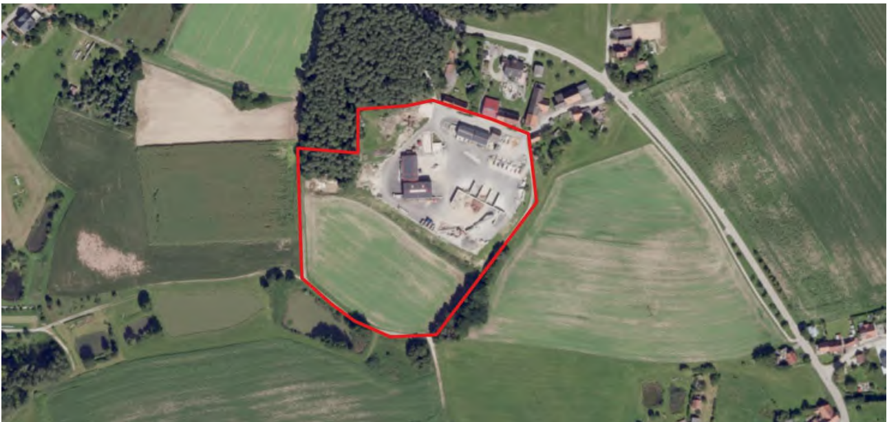
Abbildung 2: Übersicht über das Vorhabengebiet (rot umrandet). In der nördlichen Hälfte befindet sich der Baustoffhandel der Graßmüller GmbH & Co. KG; (Quelle Hintergrundluftbild: © LDBV)
