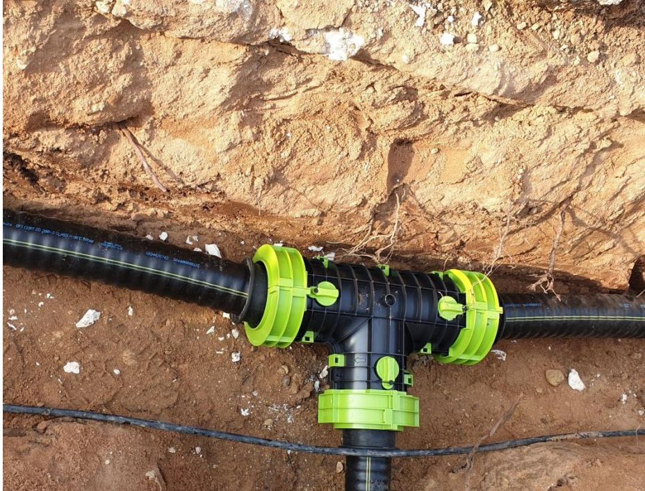
T-Stück im offenen Graben
