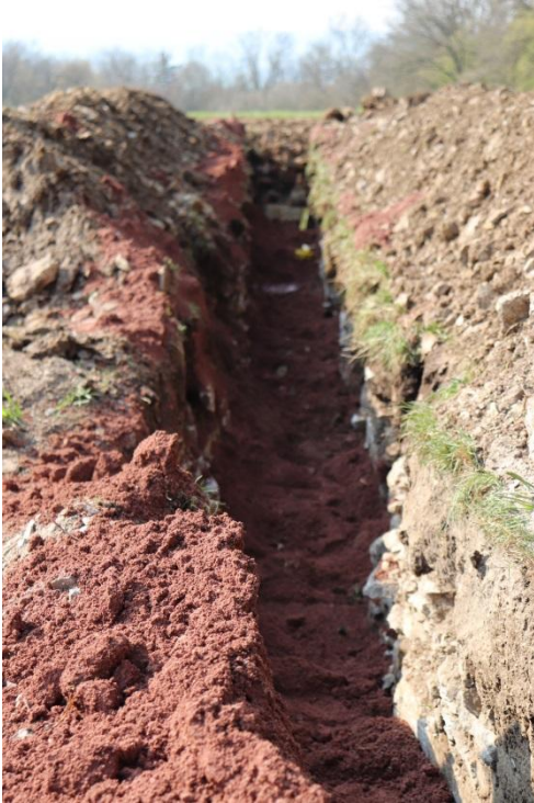
Schließen des Rohrgrabens
