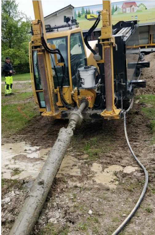
Grabenlose Verlegung im günstigen Spülbohrverfahren
