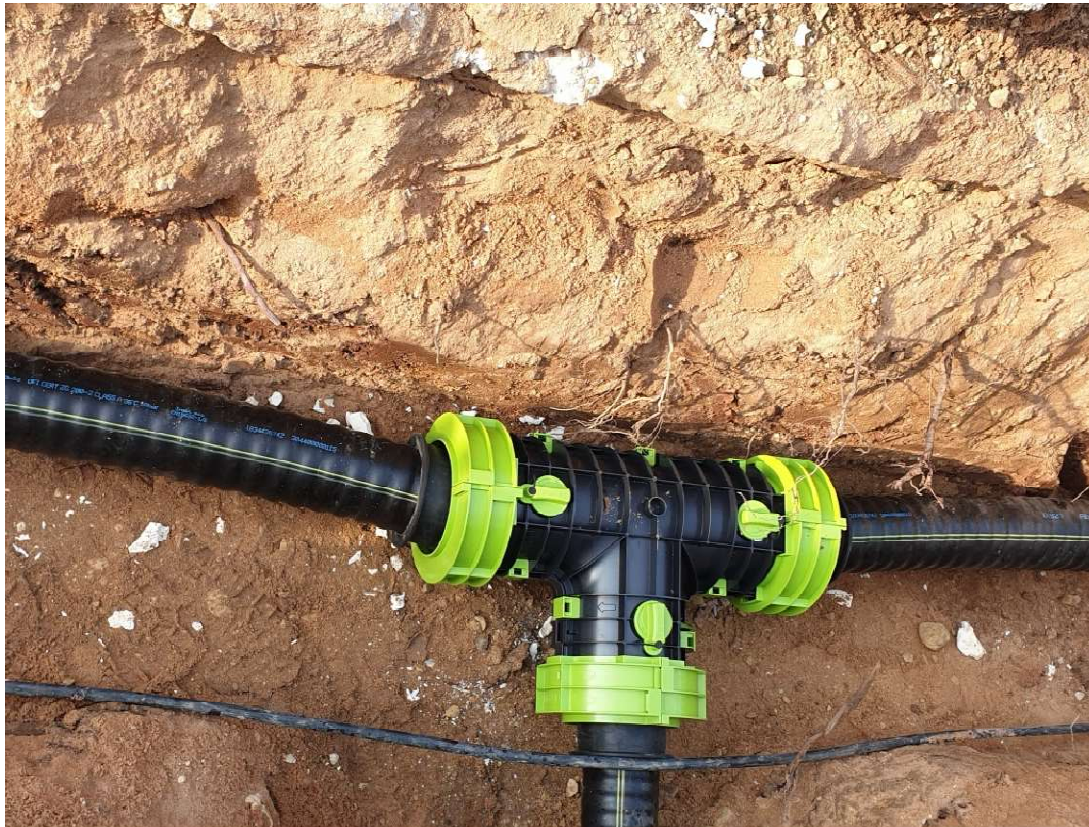
T-Stück im offenen Graben
